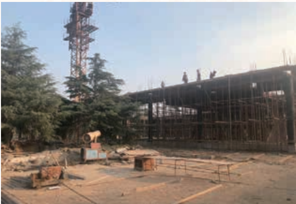
Funeral Parlor under construction 興建中之殯儀館
