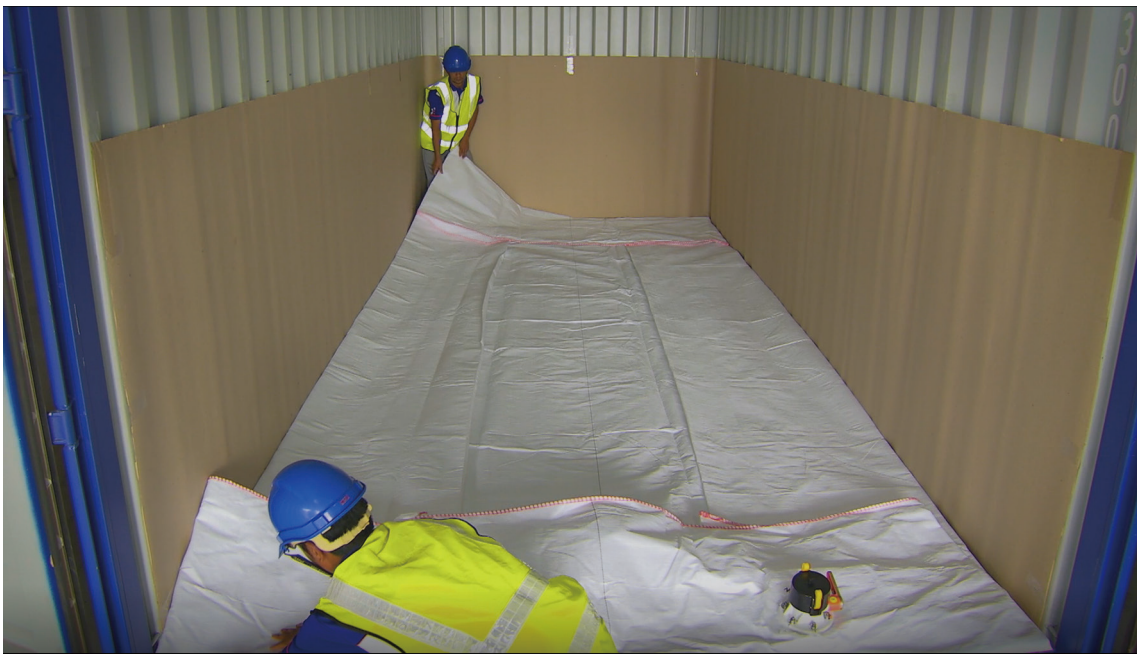
— 專門服務團隊將空集裝箱液袋裝設及安裝於集裝箱
