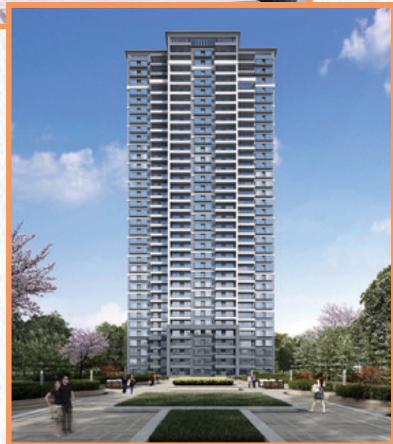
4 KUNMING GUAN DU PROJECT 昆明官渡項目
