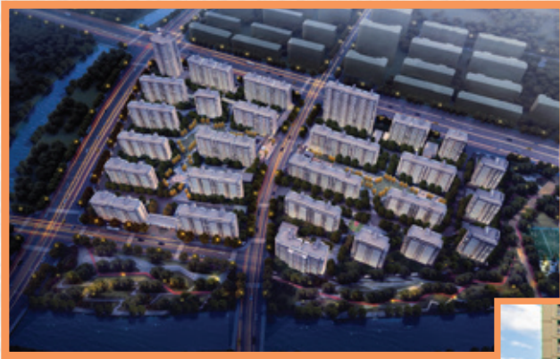
3 NINGBO SHENG MEI LU PROJECT 寧波盛梅路項目
