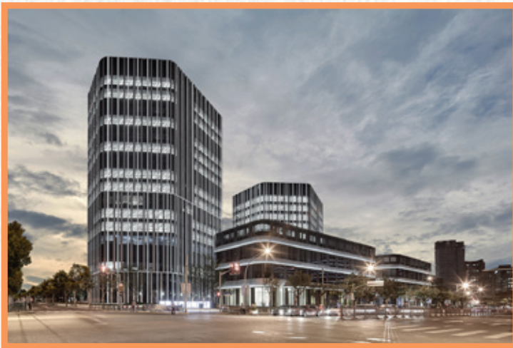
1 SHANGHAI POLY GREENLAND PLAZA 上海保利綠地廣場
