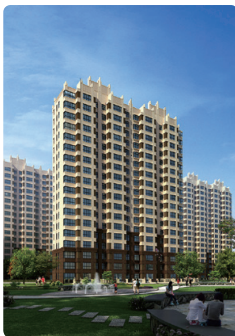
Yinchuan Project 銀川項目
