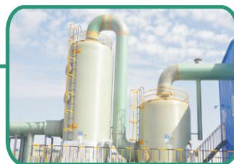
為控制發酵車間產生的苯乙酸與回收苯乙酸過程中所釋出的異味，內蒙古公司以「冷卻+鹼噴淋+活性炭吸附」等處理工藝，有效遏止異味逸散。
