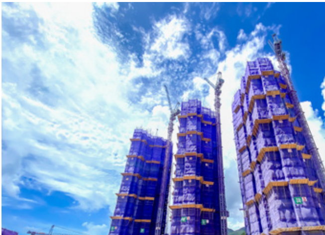
在西沙發展項目中應用防撞系統並設置5G遙遠控制天秤系統
