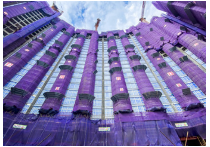
啟德建築地盤的金屬棚架
