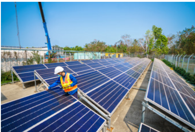
十四鄉項目的建築工地
