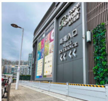
海天晉匯安裝的水閘
