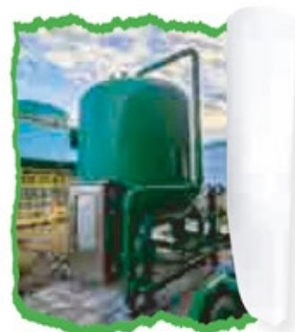
冷卻循環水旁濾系統
