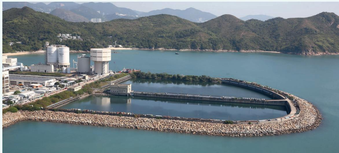
港燈南丫發電廠產生的 100% 煤灰和石膏均由第三方重用於工業用途。發電廠內建有貯存灰庫、石膏庫和煤灰湖。
