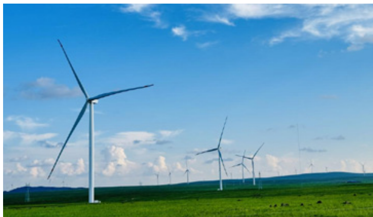
■ 中信泰富能源所屬錫盟 1000MW 風電項目
