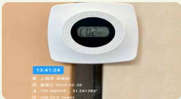
鴻壽坊辦公樓電梯廳安裝的室內空氣質量實時監測系統(左)和鴻壽坊俯瞰(右)
