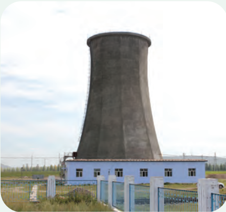
鄂溫克旗冷卻塔改造項目
