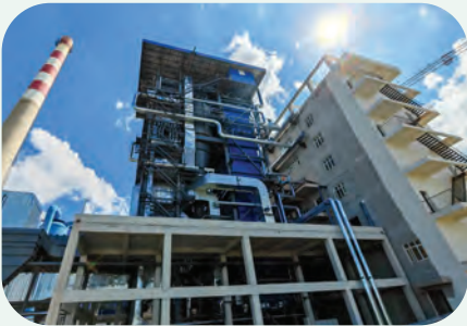
曹縣項目新建116兆瓦鍋爐項目
