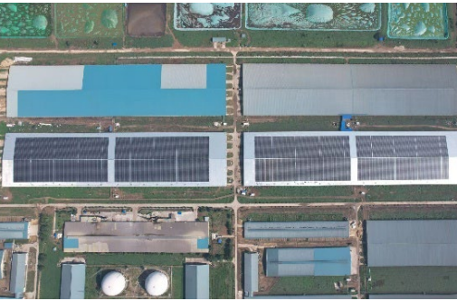
蚌埠牧場 10 兆瓦光伏發電項目已正式並網運行
