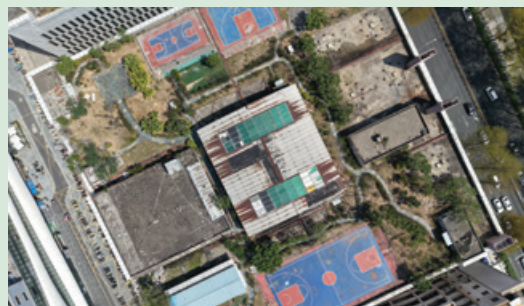
無人機巡檢筍崗車城施工
