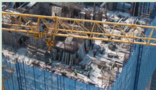
無人機巡檢銀盈大廈施工
