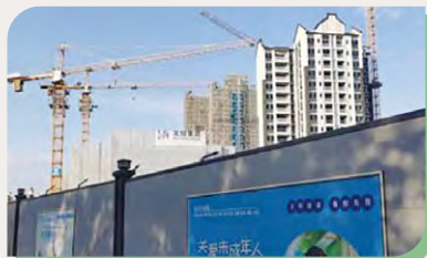
工地降塵噴淋設施
