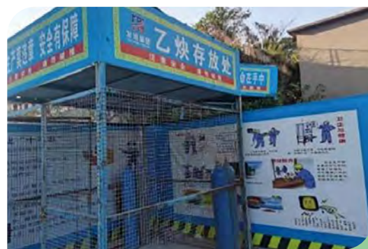
易燃、可燃材料堆放區域
