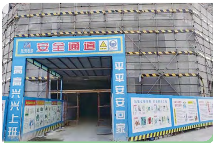
施工安全通道
