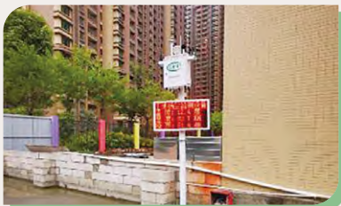
揚塵監測設備
