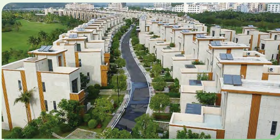
海南清水灣3號安裝太陽能系統
