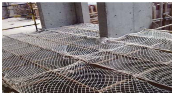
▷ 設置洞口防護
