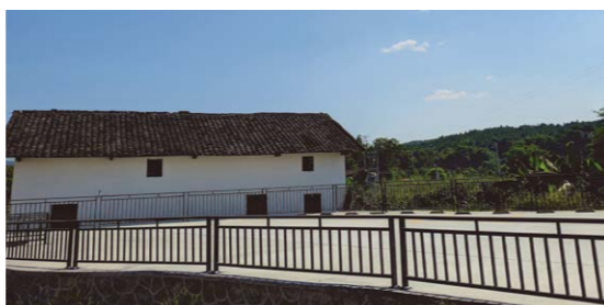
▷ 停車場改造後
