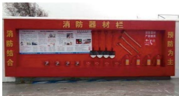
▷ 設置消防器材欄
