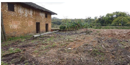
▷ 停車場改造前
