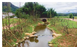
▷ 2019年7月，完成河富村大井河道改造工程。
