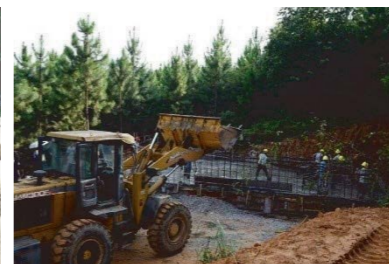
▷ 蓄水池安裝施工過程
