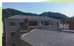
▷ 2019年9月，完成角灣新屋組24套居民外立面工程。
