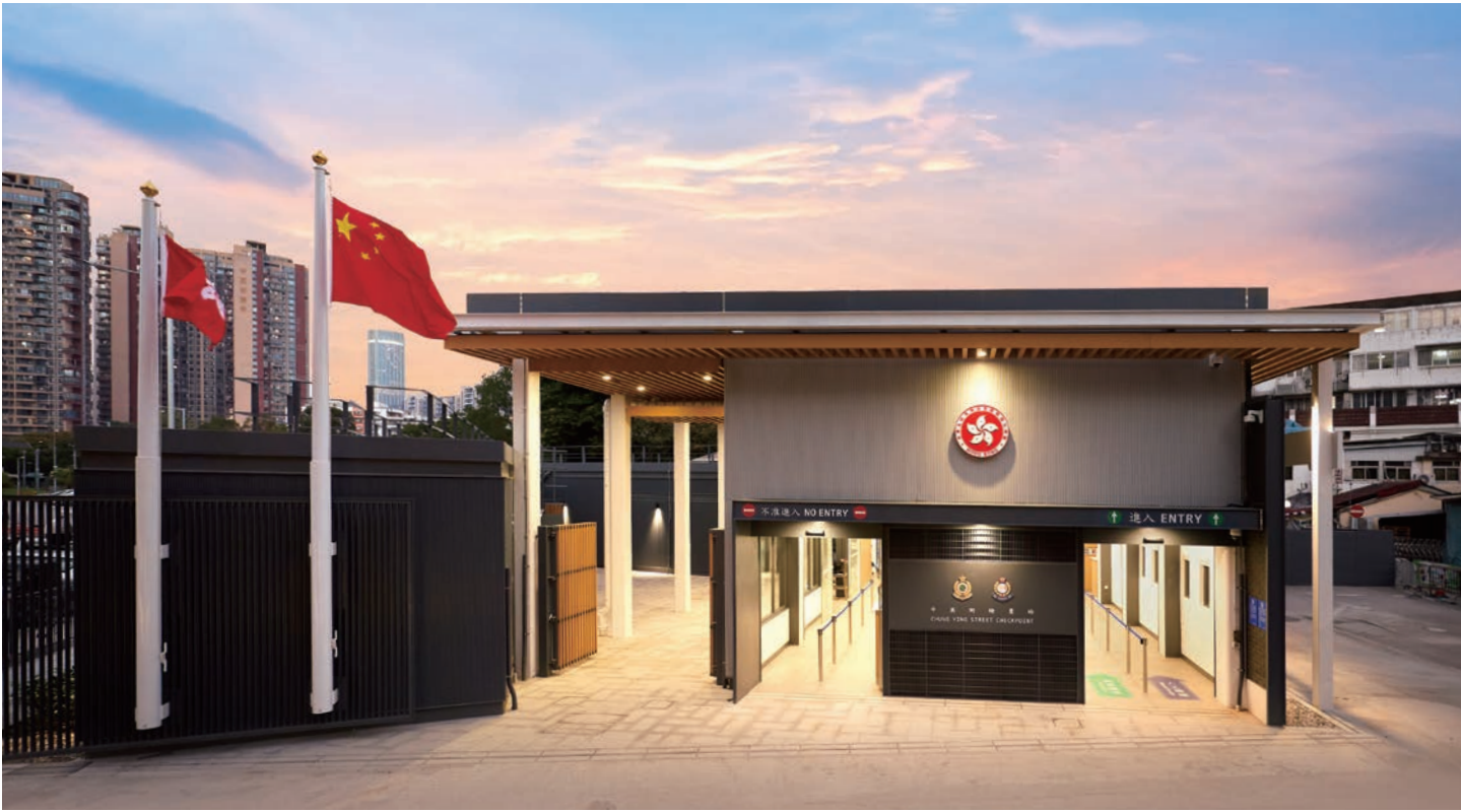
沙頭角邊境檢查站重建計劃
