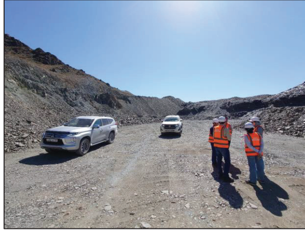
圖8.5：永久住宿營地的土方工程
