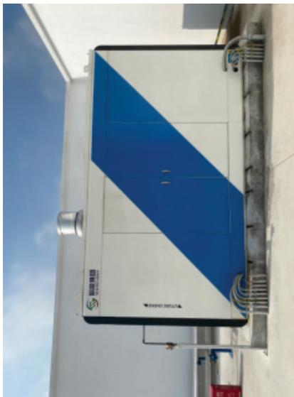
壓縮機類型：隔膜式／液驅泵
