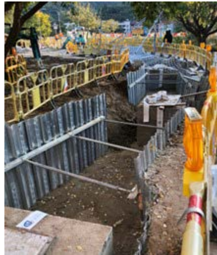
建造污水系統
