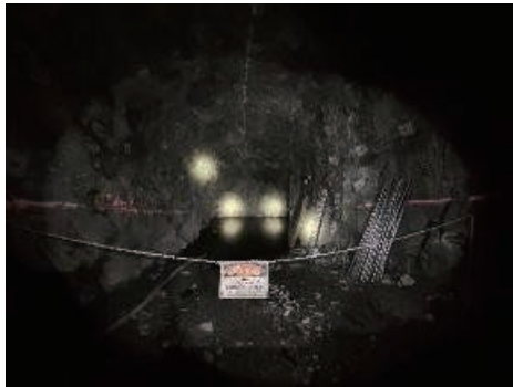
斜坡道掘進端面
