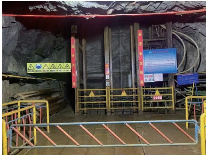
圖10-22：東風上部支洞層豎井通道
