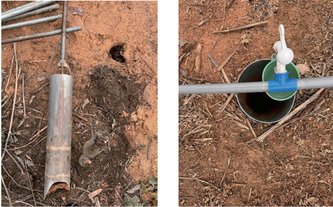
圖12-6：鑽孔及注液孔
