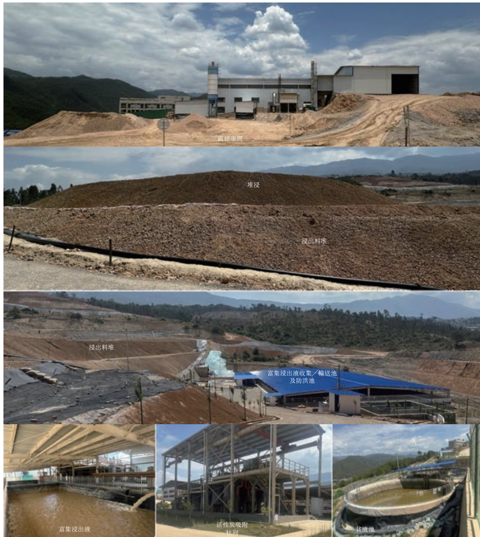
圖11-15：溪燈坪堆浸廠的主要設施照片
