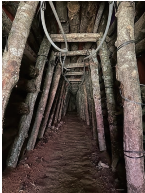
圖12-7：建造中的主富浸溶液收液隧道
