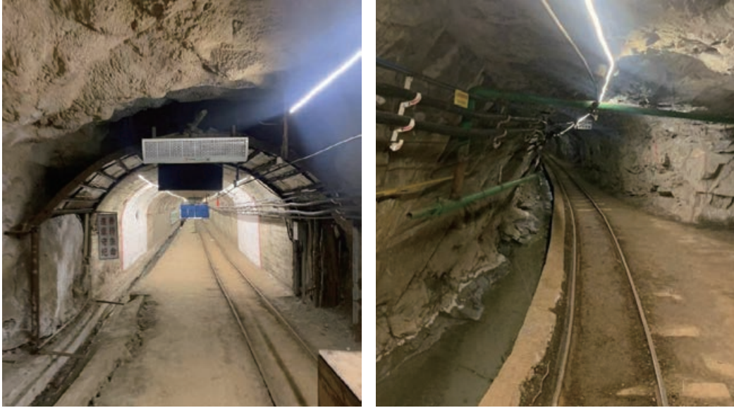
圖10-20：東風礦三中段平硐通道及巷道照片
