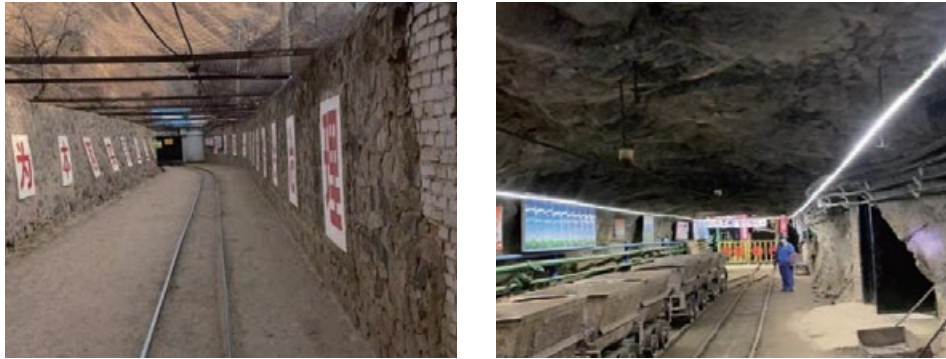
圖10-6：五中段主平洞入口及井底車場照片
