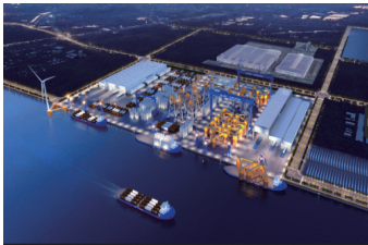
河北唐山曹妃甸海工基地
