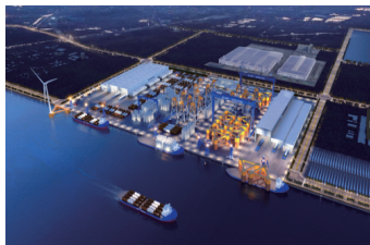
河北唐山曹妃甸海工基地
