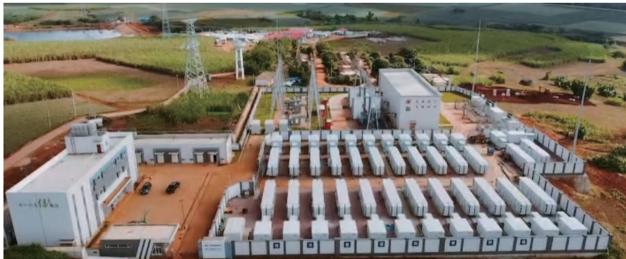
我們提供勘察、設計及諮詢服務的光伏電站升壓變電站及儲能電站
