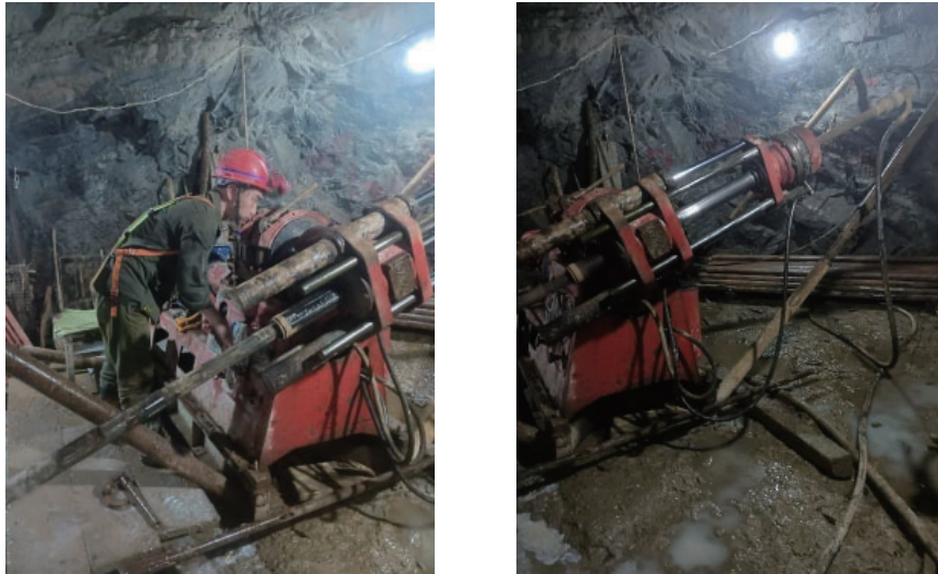
圖 10.4：地下金剛石鑽探工程
