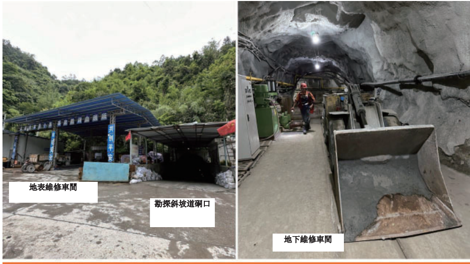
圖 16.10：地表及井下維修車間
