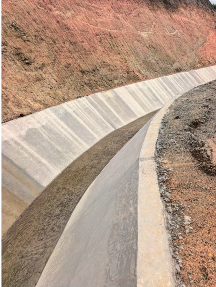
圖 18.10: TSF 等設施下游已建成防滲結構
