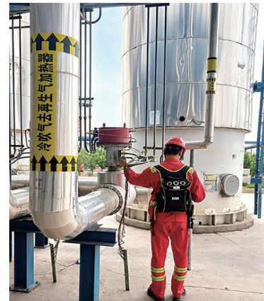
對石油化工設施進行洩漏檢測
