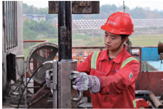
對鑽井平台進行井下油管漏氣檢測
