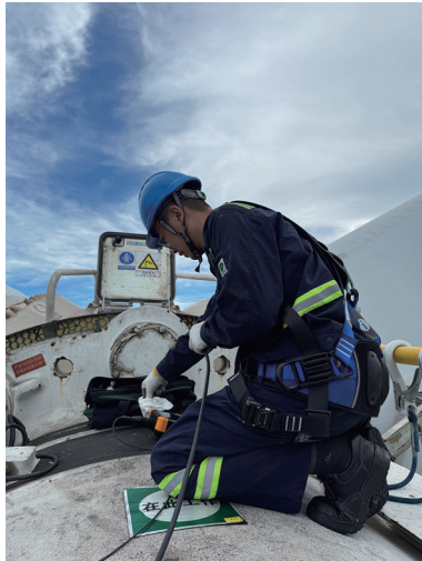
對營運中風力發電機進行測試
