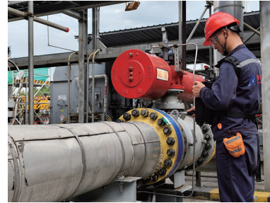
在生產站使用便攜式氮氣檢漏儀 進行洩漏檢測
