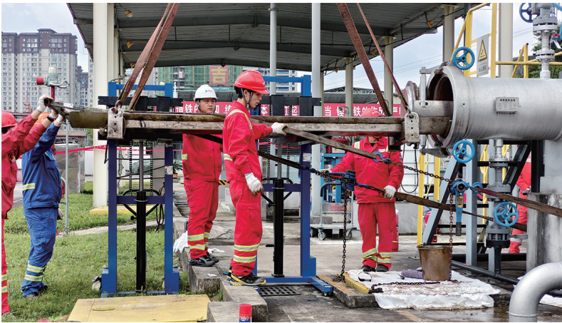
對管道發射器進行漏磁在線檢測
