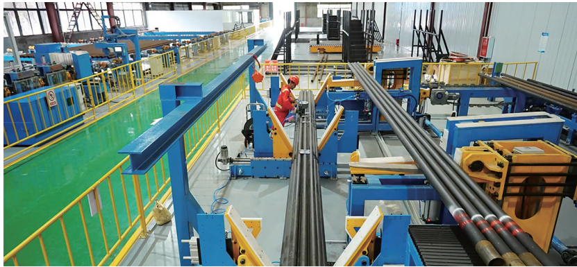
進行油套管的檢驗與維修
