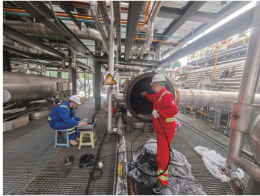
對工藝站的換熱器進行渦流檢測
