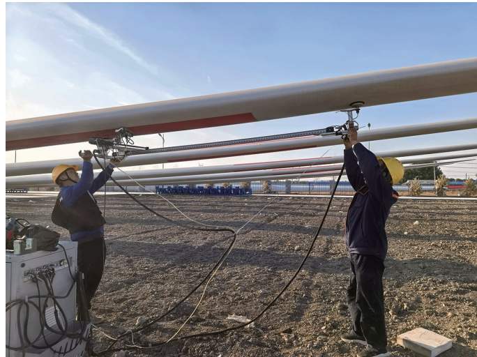
對風力發電機葉片進行安裝前無損檢測
