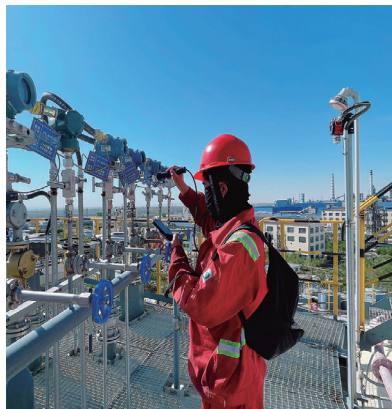
對液化天然氣設施進行洩漏檢測
