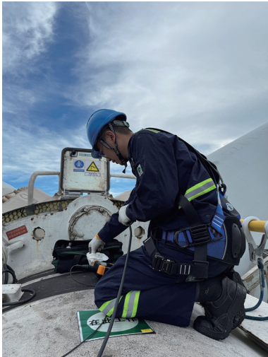
對營運中風力發電機進行測試
