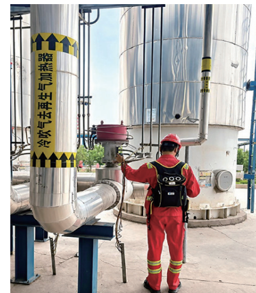
對石油化工設施進行洩漏檢測
