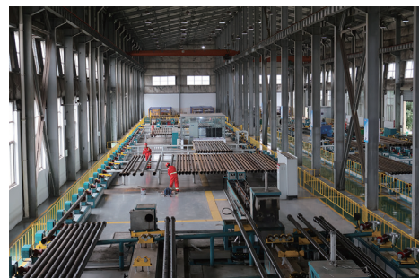
自動化鑽具檢測及維修車間
