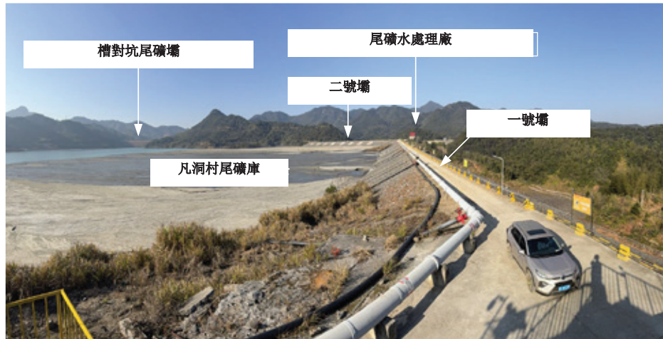
图 10-9：大寶山尾礦貯存設施照片
