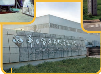
於廊坊之生產廠房及生產設施
