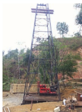
Drilling work in Indonesia 印尼鑽探工作
