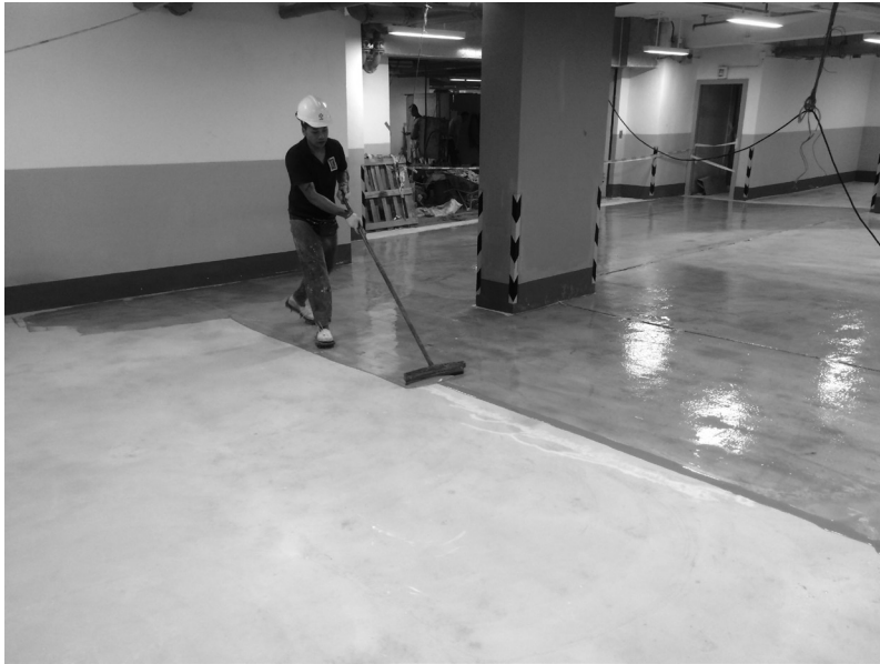
(vi) 噴撒石英砂到底油上面以製造摩擦
