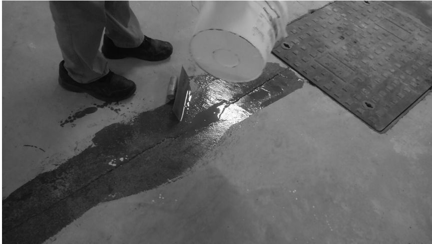
(iii) 地面整修－修復地面裂縫
