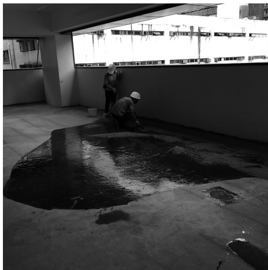
(iv) 地面整修－底層缺陷修補工程
