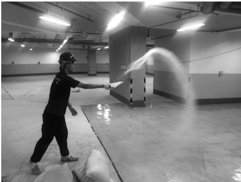
(vi) 噴撒石英砂到底油上面以製造摩擦
