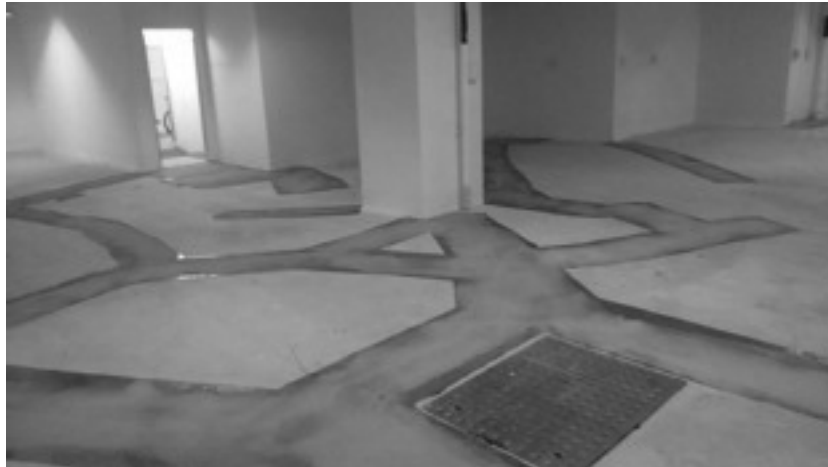
(iv) 地面整修－底層缺陷修補工程
