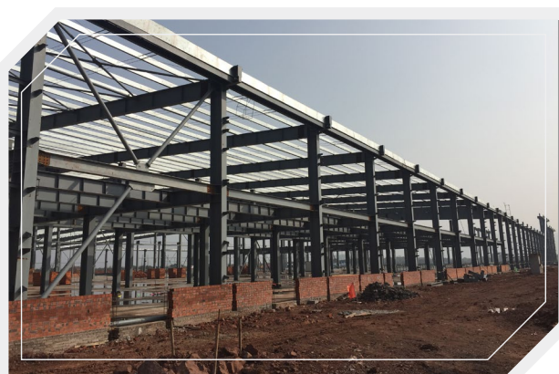
浙江衡遠新能源工廠現正動工
