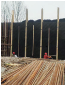
建設物流中心第一期工程
