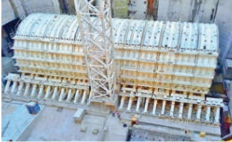
鋼製管片隧道
