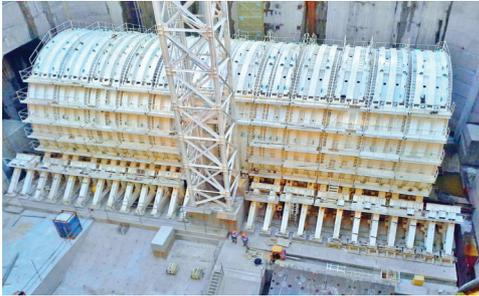
鋼製管片隧道
