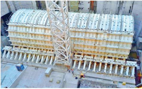
鋼製管片隧道
