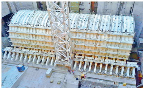
鋼製管片隧道
