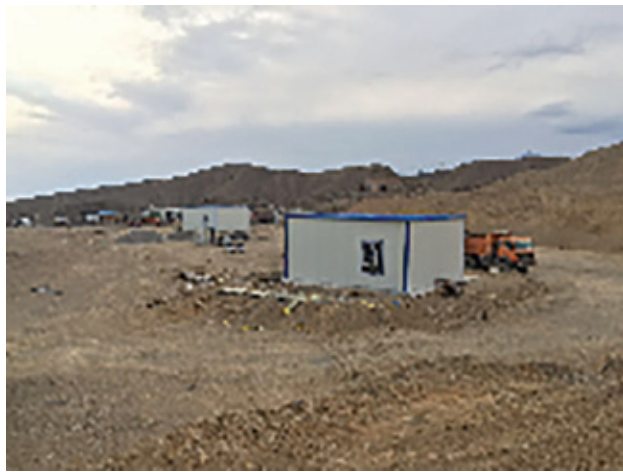
施工現場作業圖(2)
