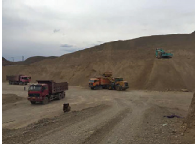
施工現場作業圖(1)
