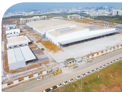
全部主要建築工程均已完成
