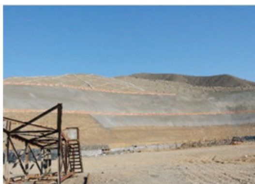
斜坡防護工程
