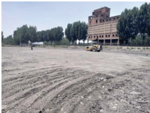
煤炭物流園二期新平整土地
