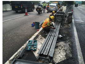
更換及維修防撞欄
