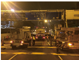
拆除道路指示牌
