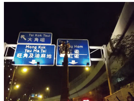
更換及維修道路指示牌
