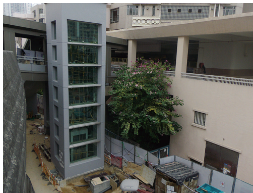
建造升降機大樓
