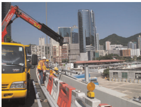
更換及維修鋼護欄
