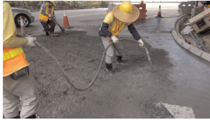
鋪設混凝土路面
