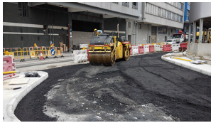
鋪設瀝青路面
