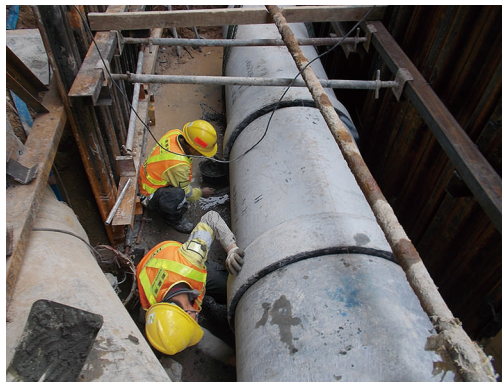
排水系統的石屎渠筒安裝
