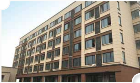
> 浙江衡遠新能源行政大樓
