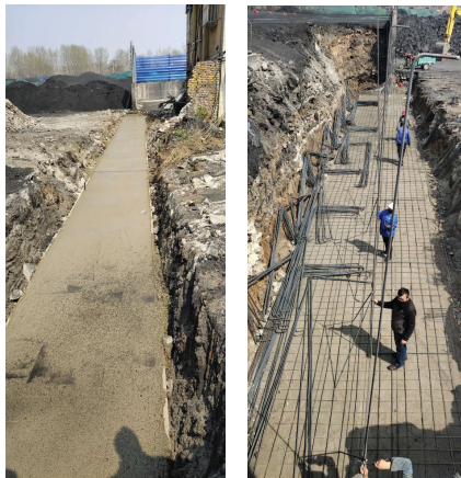
山東凱萊使用水泥與鋼筋以鞏固及拓寬月台
