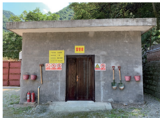
雷管庫外的安全設備
