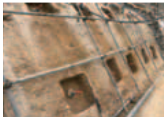
土釘鑽孔及安裝
