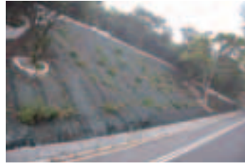
安裝金屬絲網和防蝕墊以控制侵蝕程度
