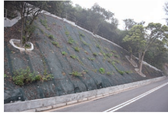
安裝金屬絲網和防蝕墊以控制侵蝕情況
