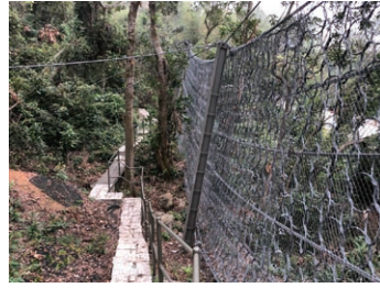
建造柔性防護網系統
