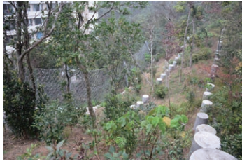
安裝泥石流保護剛性屏障
