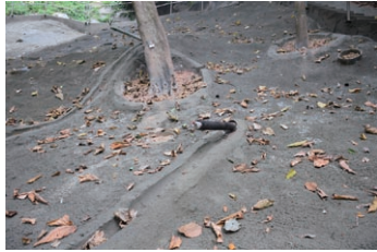
安裝排水斜管
