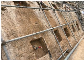
土釘鑽孔及安裝
