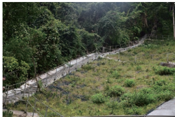
建造混凝土維修樓梯／通道
