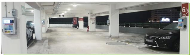
系統的停車場。負荷管理系統有效使可用電力供應最大化，在不增加電力負荷的情況下同時安裝並使用更多充電器。
