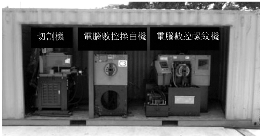
位於車間的三種機械鋼筋並接機
