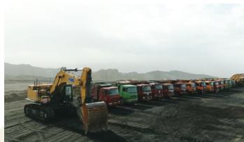
各類施工機械在礦區待機
